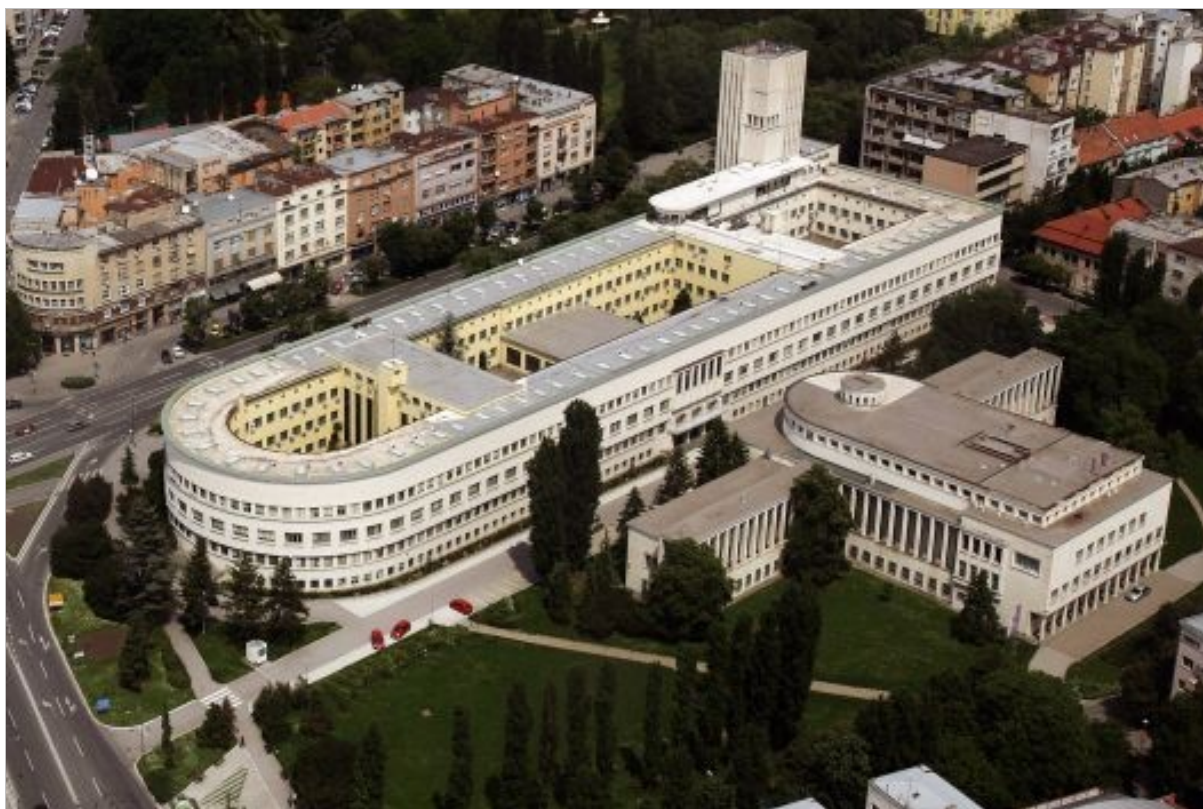
Слика 12: Седиште Скупштине АП Војводине и Покрајинске владе
